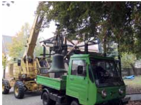
Die Glocken werden demontiert und verladen.
