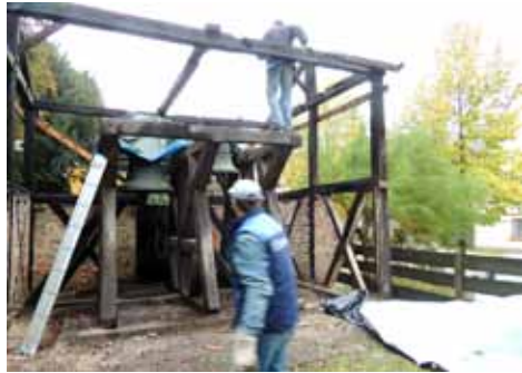
Dach und Umhausung sind schon zurück gebaut
